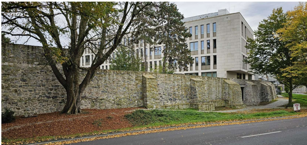
Graben an Grabenstraße, Nähe Versorgungseinfahrt Rathaus
