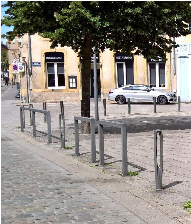
Beispiel für in den Boden eingelassene „Nadel“-Pfosten, Voll-Aluminium, beschichtet, fahrradanschließgeeignet
